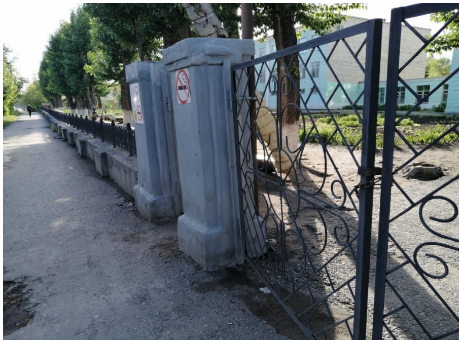
ДО РЕМОНТА (ОГРАЖДЕНИЕ ТЕРРИТОРИИ)
