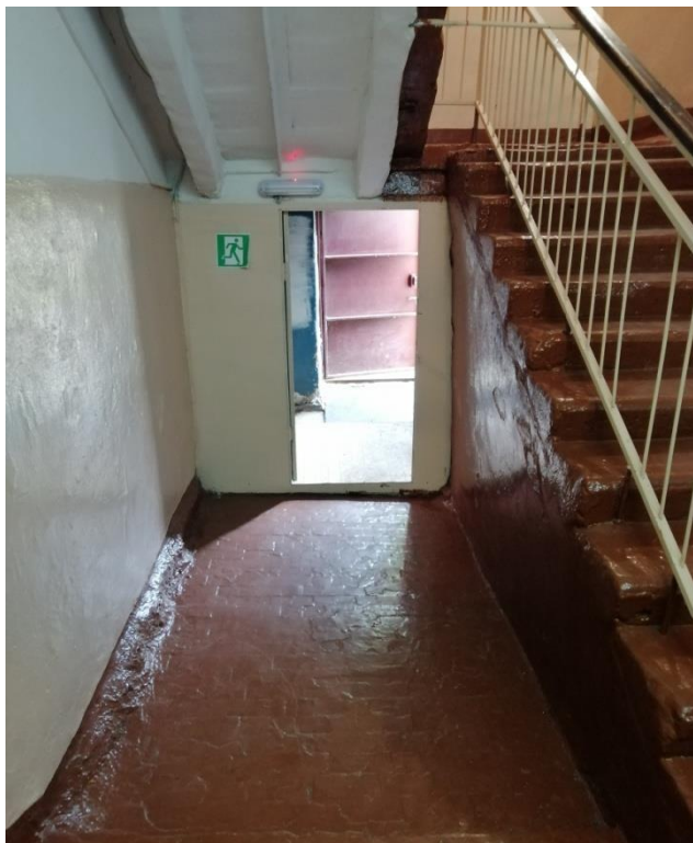
ДО РЕМОНТА (ЭВАКУАЦИОННЫЕ ВЫХОДЫ)
