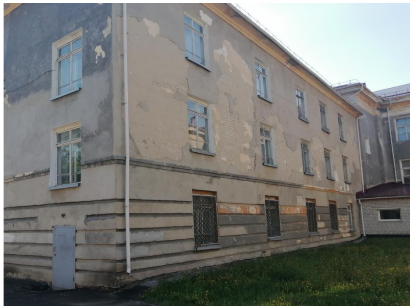
ДО РЕМОНТА (ЭВАКУАЦИОННЫЕ ВЫХОДЫ)
